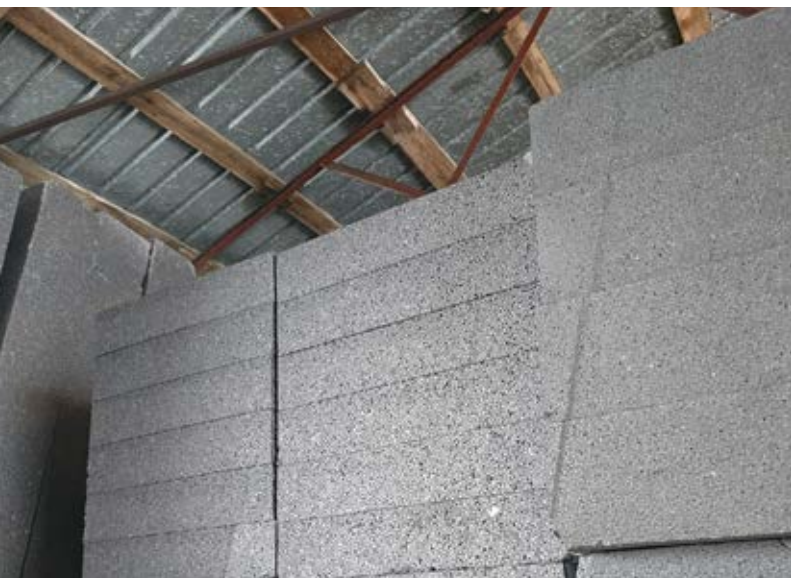
Фото 4. Правильне складування пінополістиролу на будівельному майданчику.
