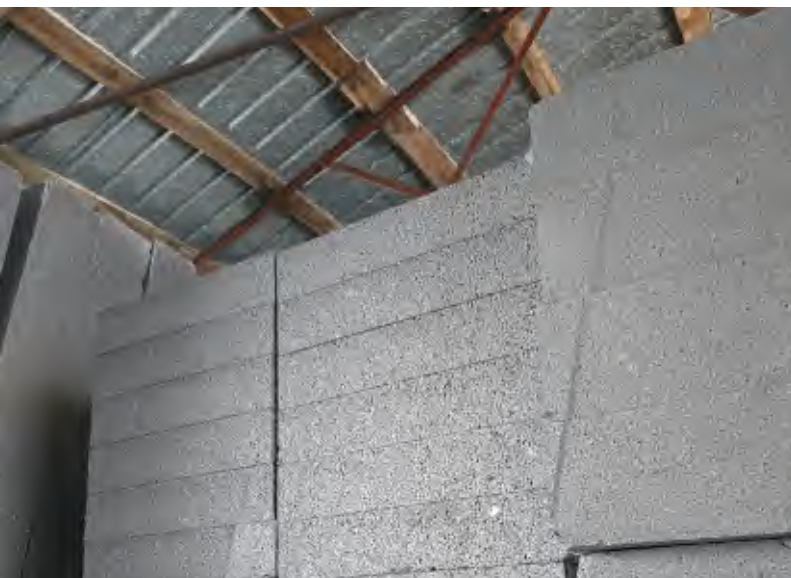
Фото 4. Правильне складування пінополістиролу на будівельному майданчику.
